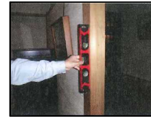
水平器による柱の傾きの計測
